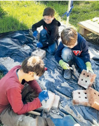
Steinbearbeitung und Mauerarbeiten von Hand für den Ofens unter Anleitung der Lehrer.
